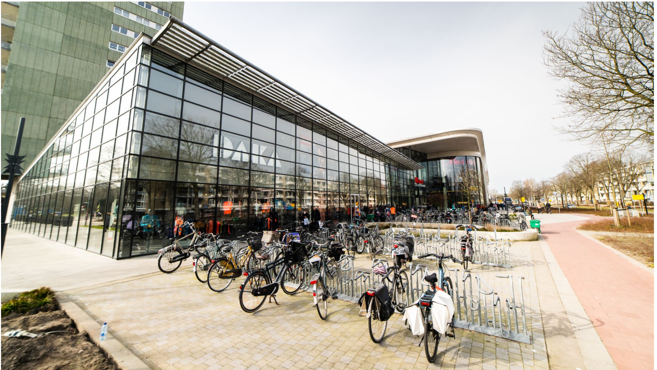
Figuur 2: De bouw van het winkelcentrum is gebaseerd op het HUECK Trigon 50-gevelsysteem met geïntegreerde HUECK Lambda DS 075-deuroplossingen (bron: HUECK)
