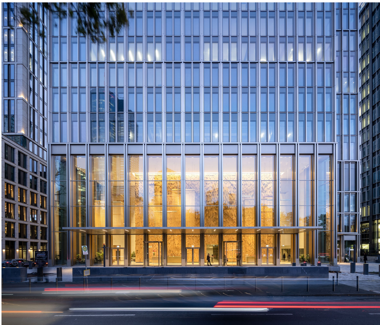
Afbeelding 3: De beknopte, verticaal gestructureerde venstergevel van glas en geanodiseerd aluminium van de vier verdiepingen hoge entree werd uitgevoerd met een stijl-/regelwerkconstructie van de HUECK Trigon 60-serie. (Foto bron: ©Pecan Development)
