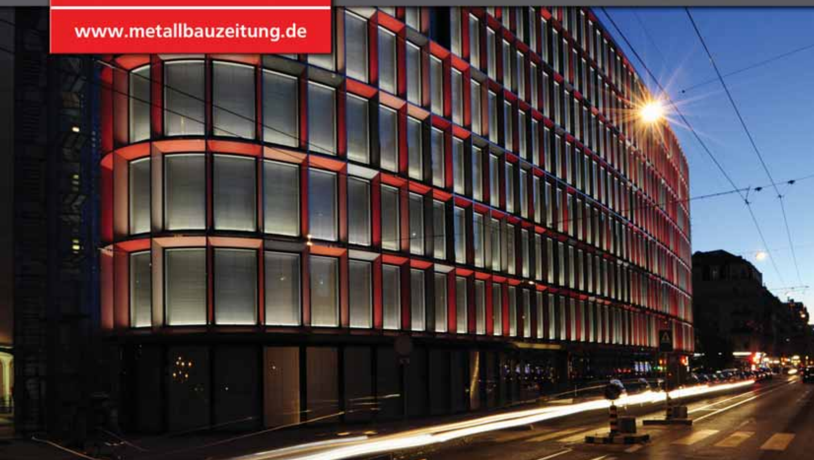
Objekt Saint-Georges-Center in Genf
